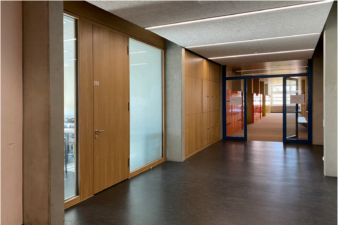
Musterzimmer korridorseitig mit neuer Eingangstürfront und Spinden.
